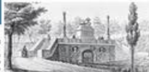
Calicata del Real Canal
