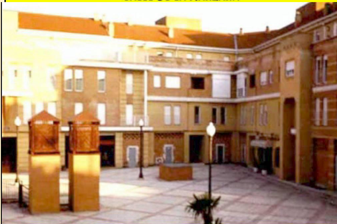
CALLE DE LA MANZANA ACTUAL
