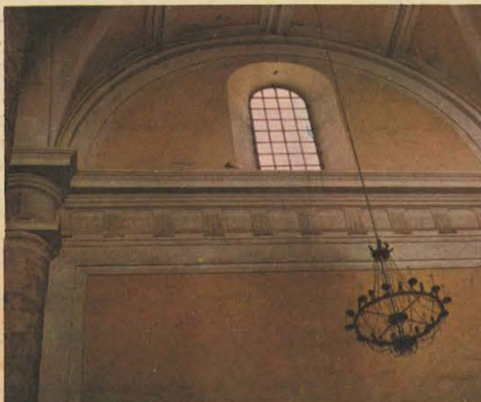
Bóveda nave central.
