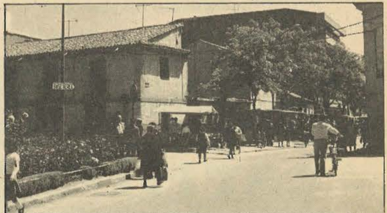
En contraste con las modernas edificaciones que han surgido en los últimos años, aún quedan en el casco urbano, casas antiguas como la que muestra la foto.
