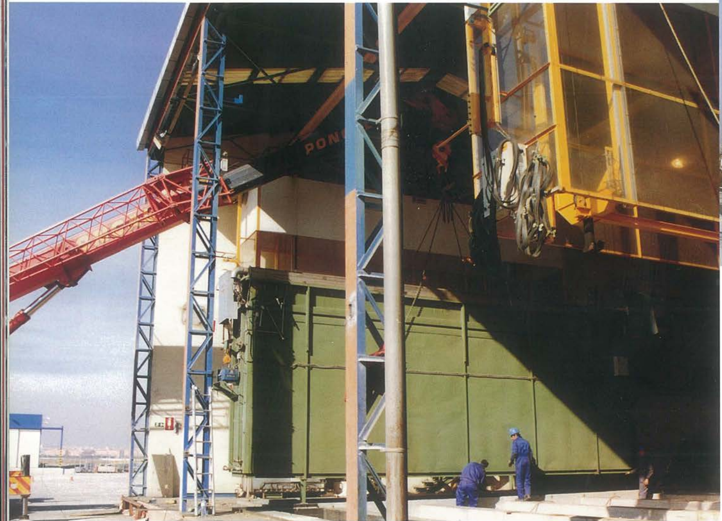
Desmontaje de las instalaciones de Baños en la Nave Central.
