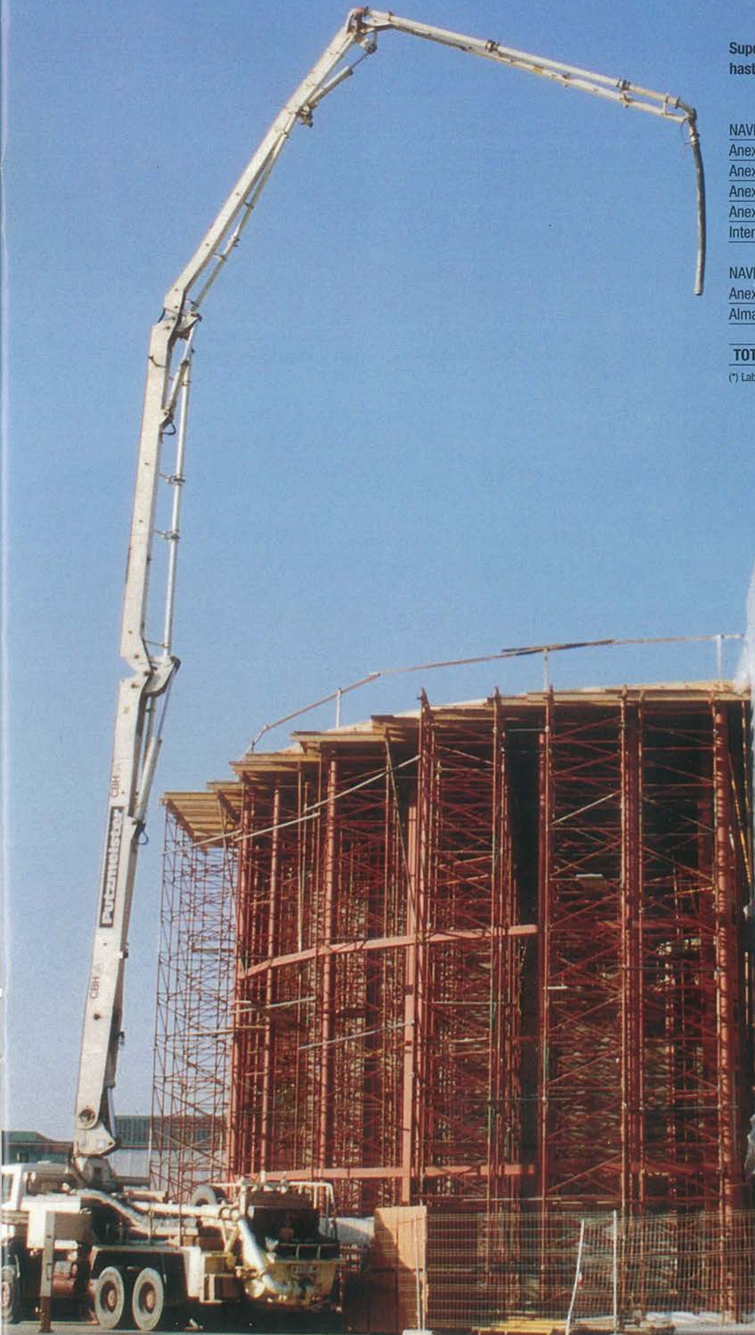
Montaje de estructuras en la nave del ET2000.
