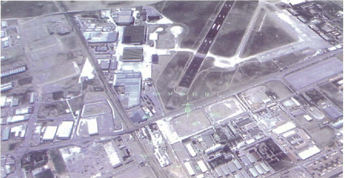
Vista de la pista de aterrizaje.
