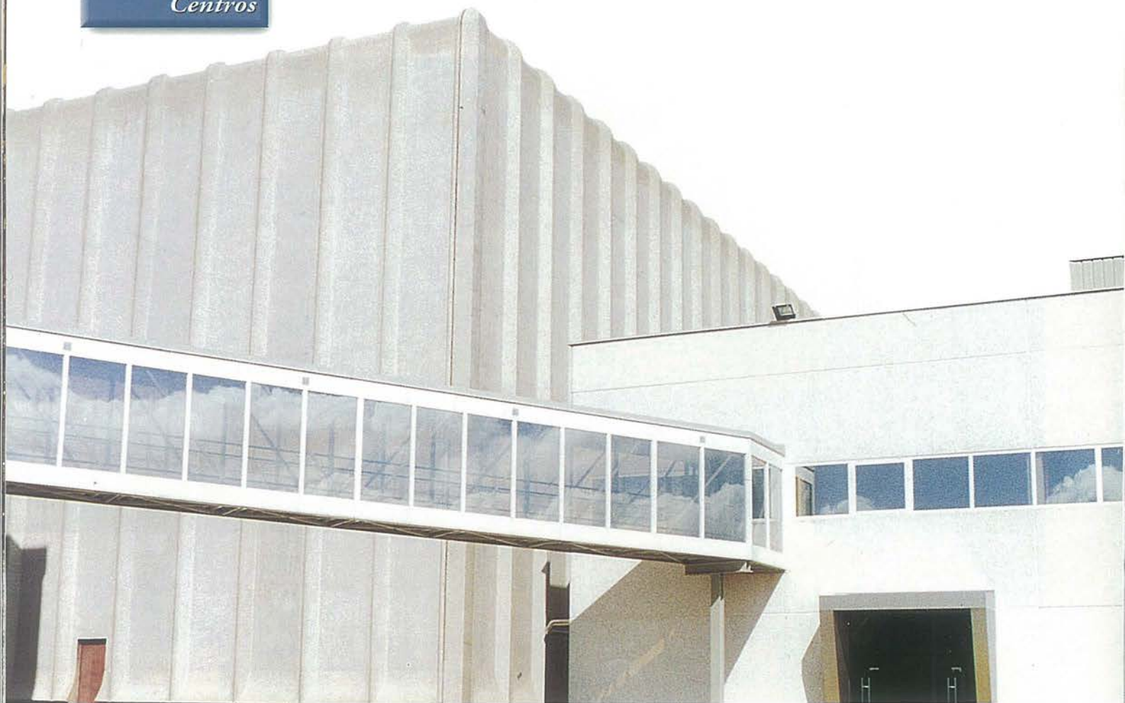
Pasarela de acceso al CIPA desde el laboratorio de Sistemas (Getafe).
