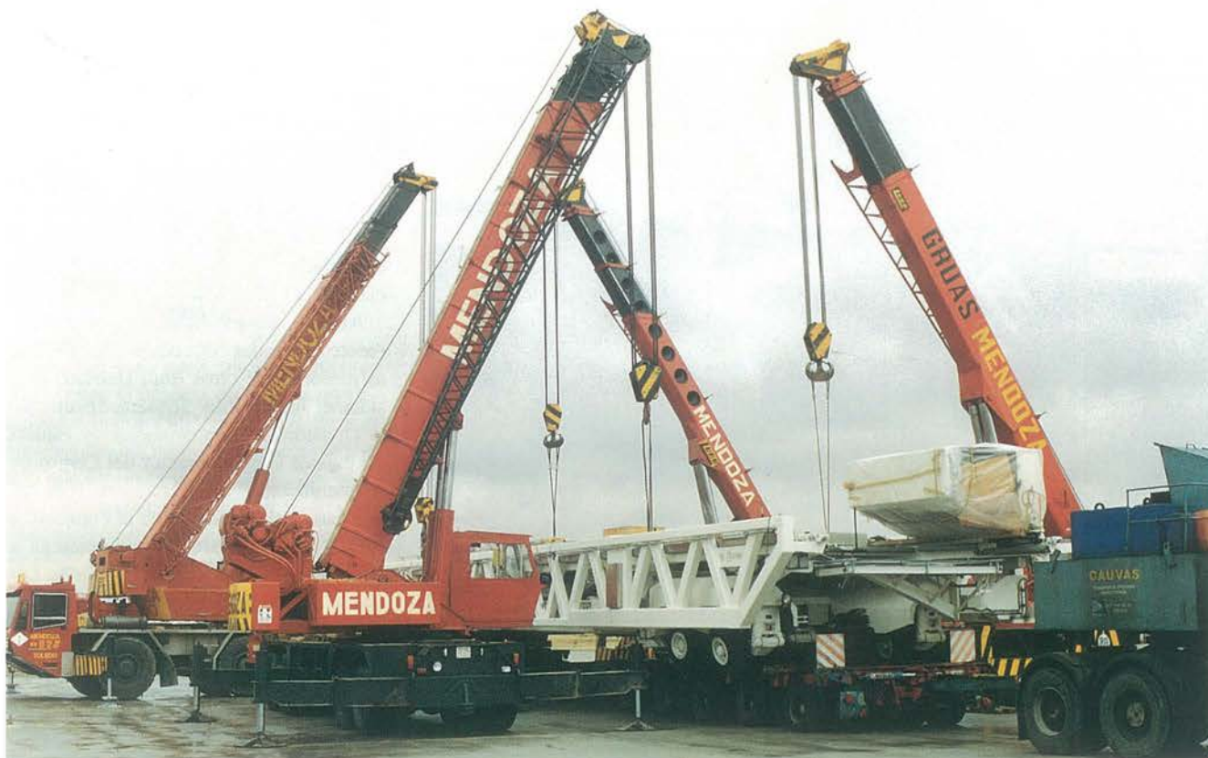
Maniobras para la descarga de la plataforma.
