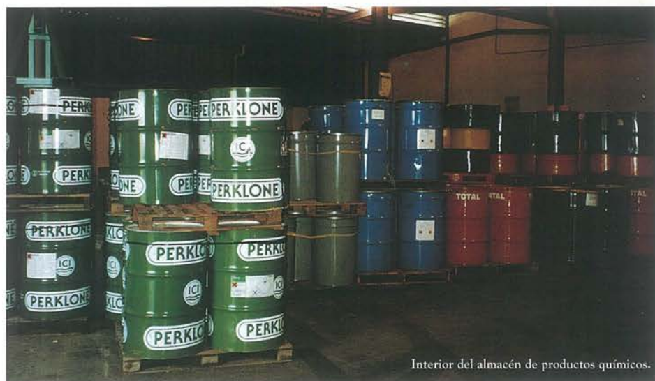
Almacén de RTP's y aceites usados (en primer plano) y de productos químicos (al fondo).
