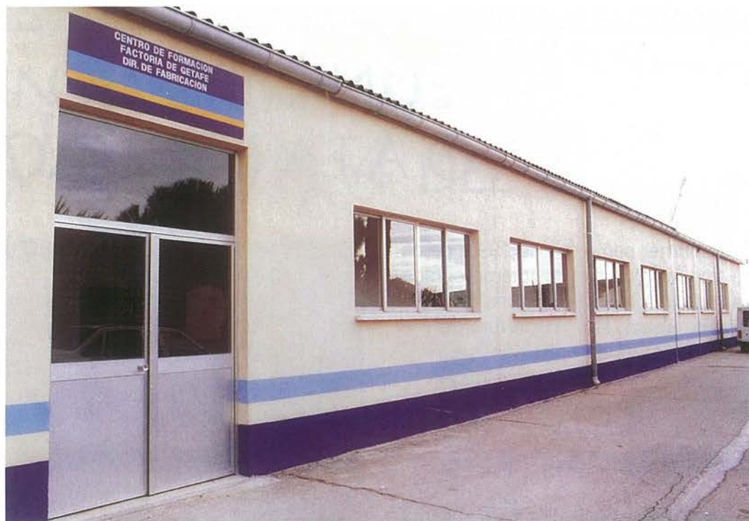
Vista exterior del Centro de Formación.
