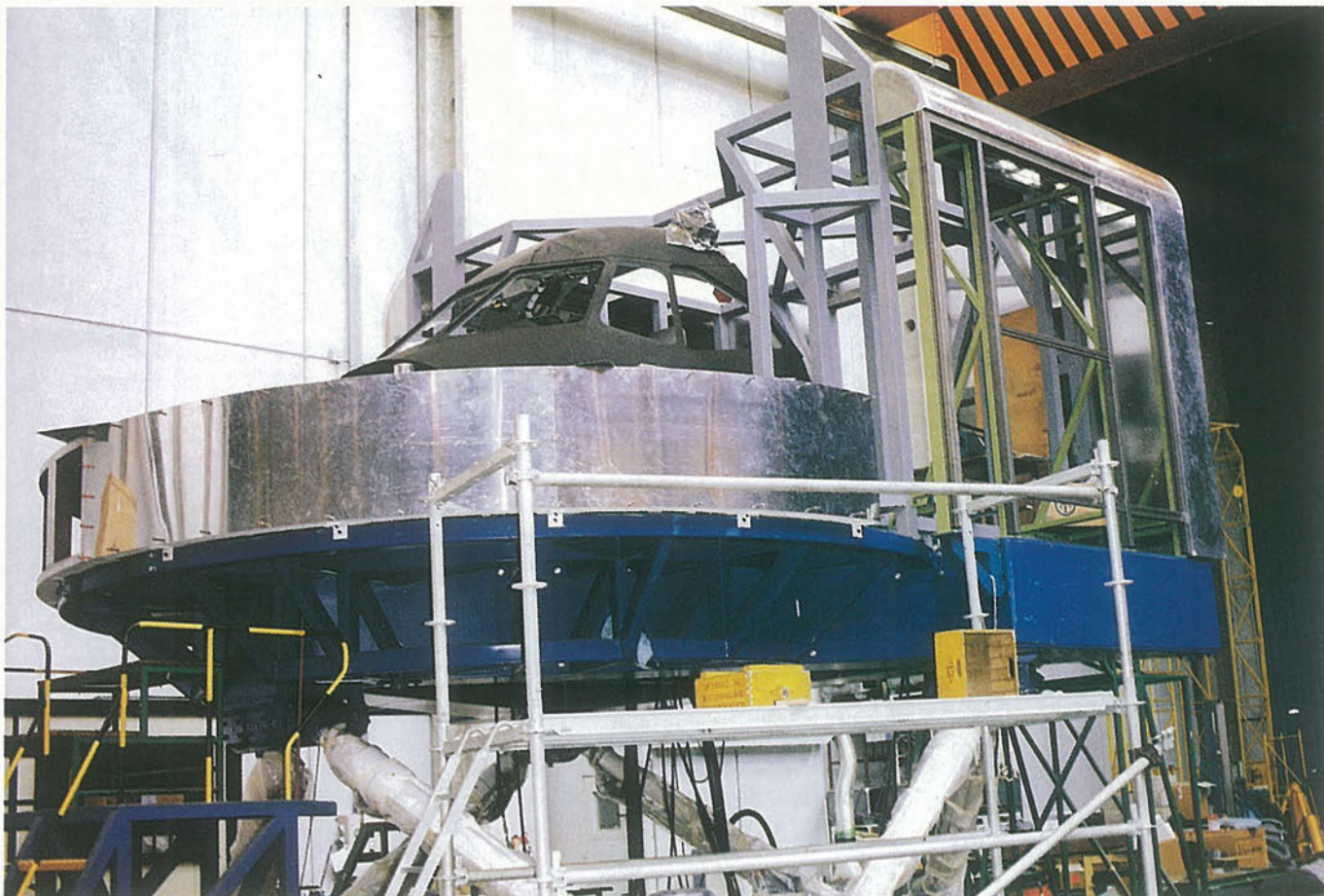
Simulador 2: Fase inicial de montaje en la nave del TMD.
