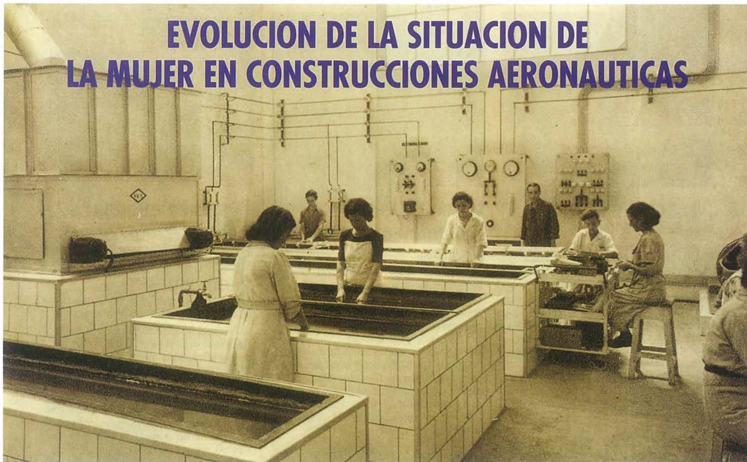
▲ Instalación de oxidación anódica de la Factoría de Cádiz (aprox. años 30).
