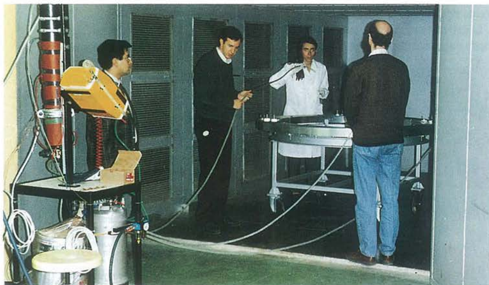
▲ Momento de la inyección de resina
