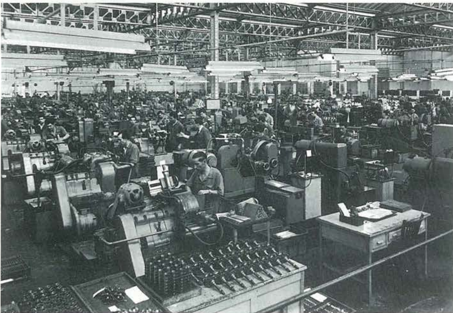
Interior de la nave de máquinas.
