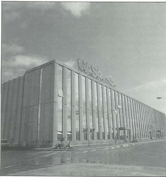
Instalaciones de Puerto Real.
