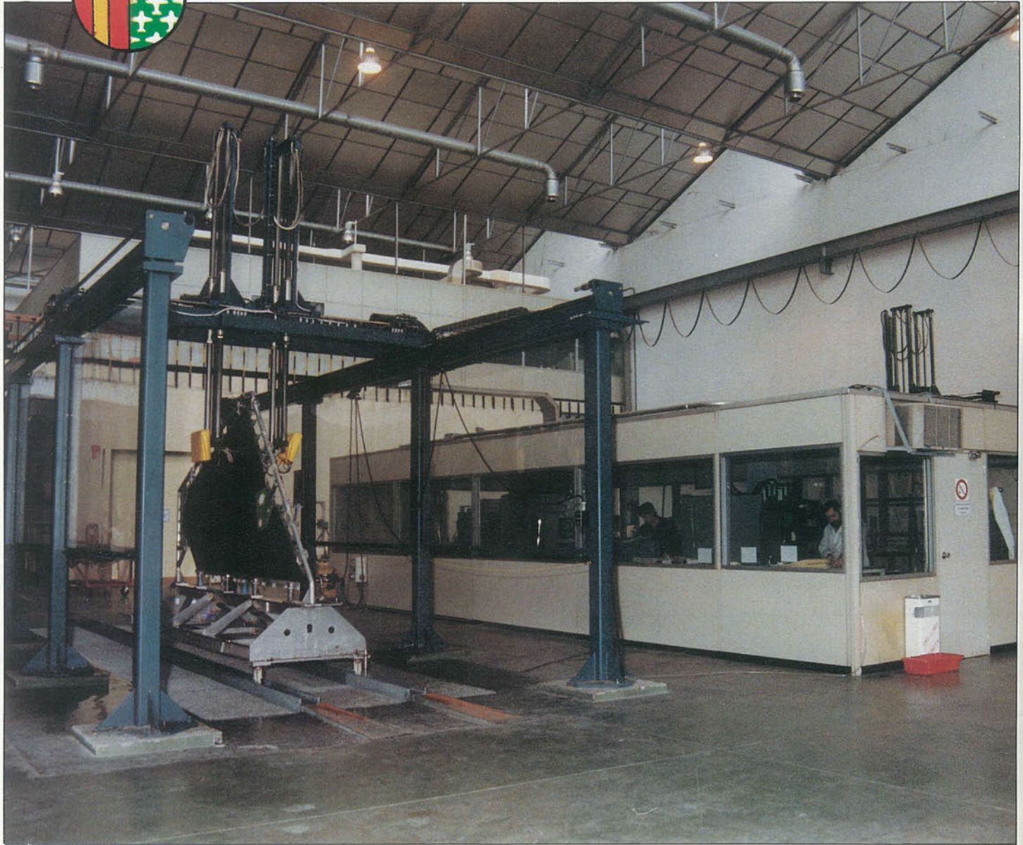
Inspección automática por ultrasonido.
