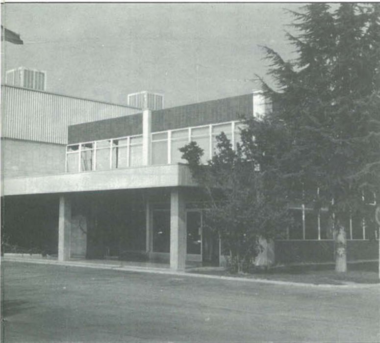
Arriba: Instalaciones de Ajalvir (Centro de Mantenimiento de Motores), a la izquierda: Un F-15 en plena operación de mantenimiento.
