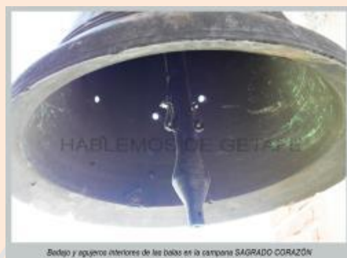
Badajo y agujeros interiores de las bolas en la campana SAGRADO CORAZÓN
