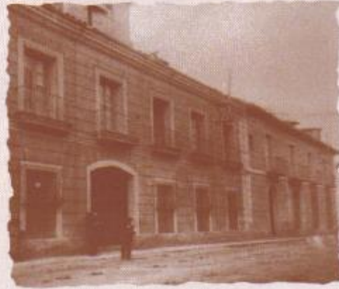
Fachada del antiguo colegio de las Ursulinas en la calle Madrid
