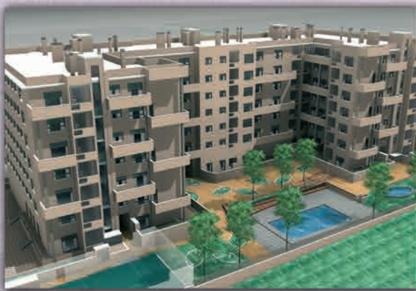
Avenida de la Paz (Edificio El Bercial-Universidad)
