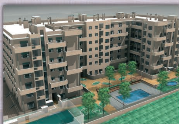
Avenida de la Paz (Edificio El Bercial-Universidad)
