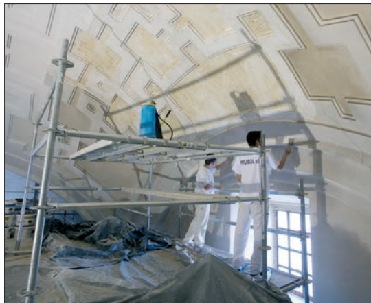
La bóveda está siendo raspada y repintada.
