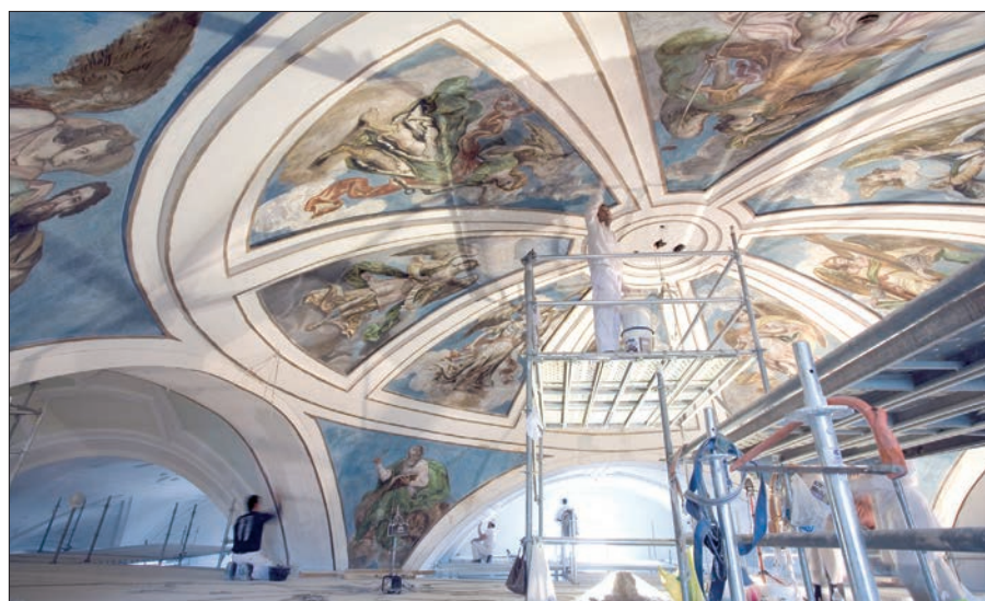
Cúpula sobre el crucero a punto de finalizar la restauración.
