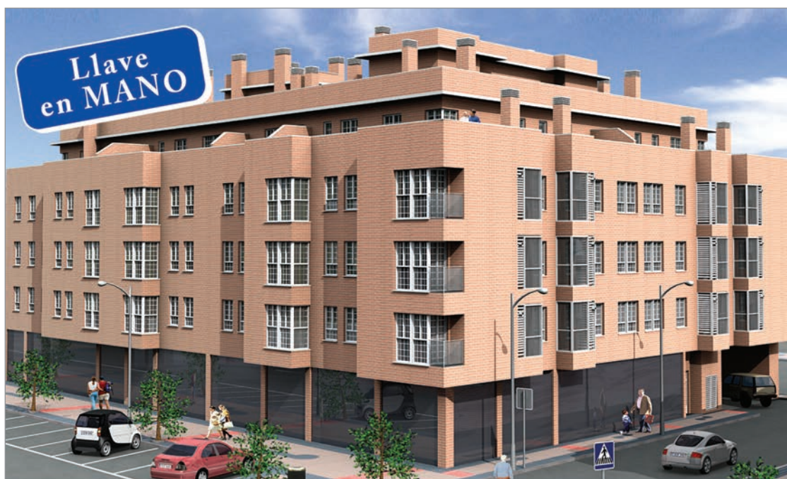
Edificio con garaje situado en la calle Madrid nº 102, el centro del casco urbano de Getafe, junto a la Universidad Carlos III.
