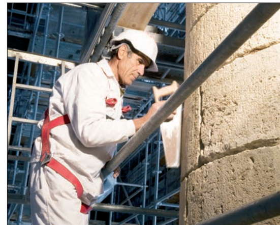
Obrero sustituyendo el rejuntao de la columna.
