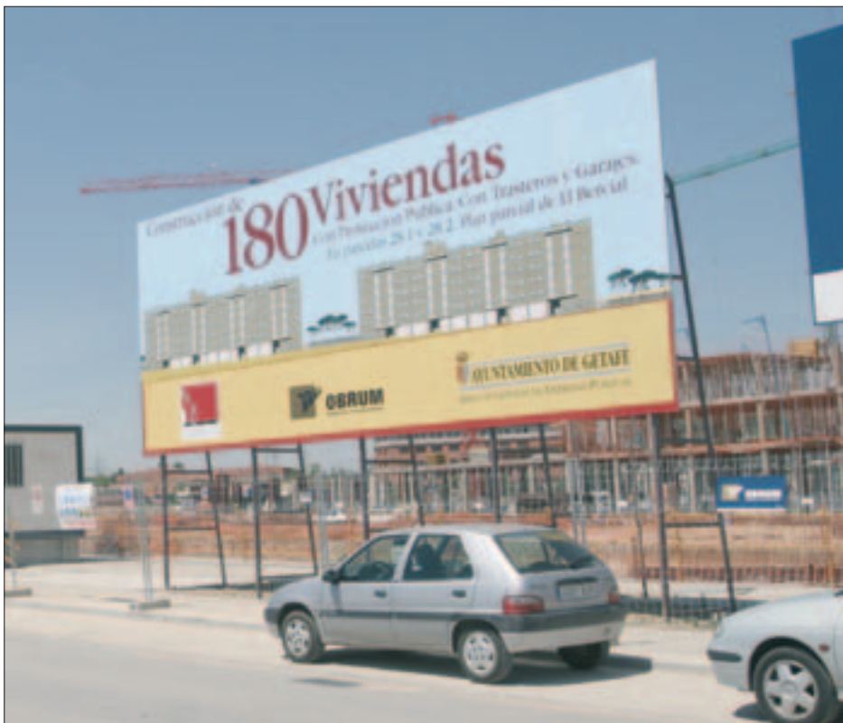
Un cartel de la EMSV identifica las dos parcelas donde ya han comenzado a construirse las 180 viviendas que promociona la empresa del Ayuntamiento.
