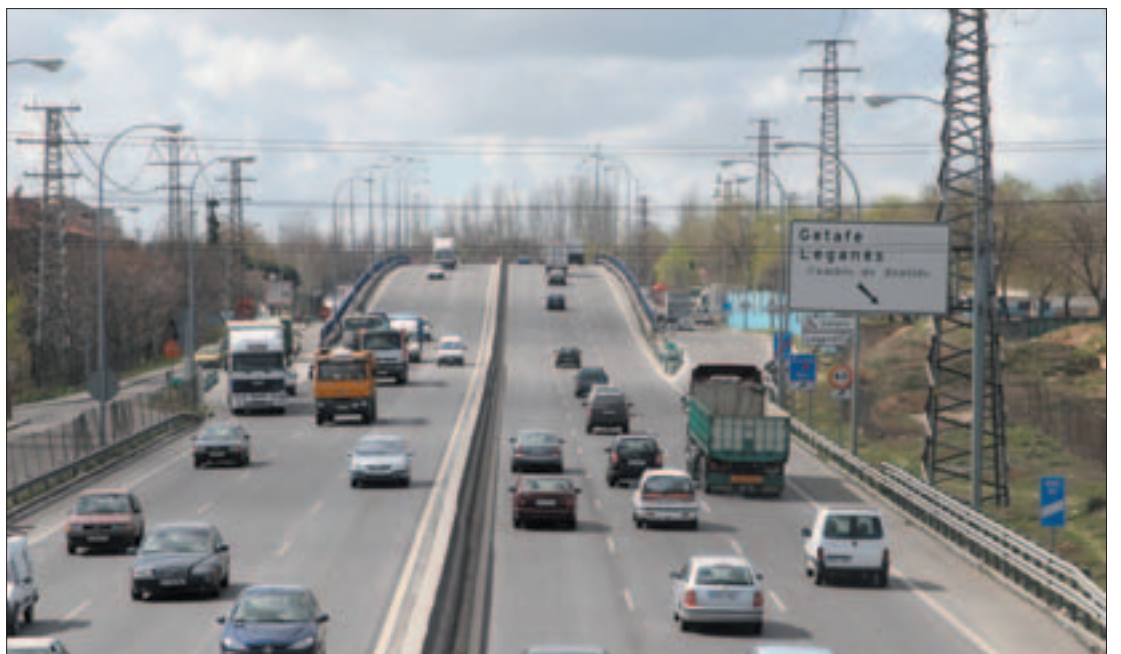
El nuevo barrio se conectará al resto de Getafe a través de tres puentes y una pasarela.
