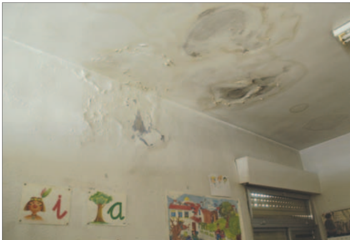
Una de las aulas del Sagrado Corazón exhibe humedades y problemas con algunas persianas.
