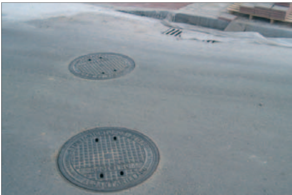
Las alcantarillas son parte de la red de agua, cuya ejecución está muy avanzada.
