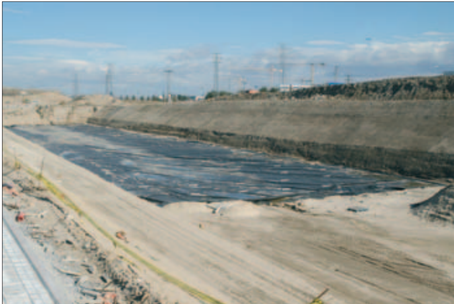
Ya está instalada la primera capa de material geotextil en la laguna de pluviales.
