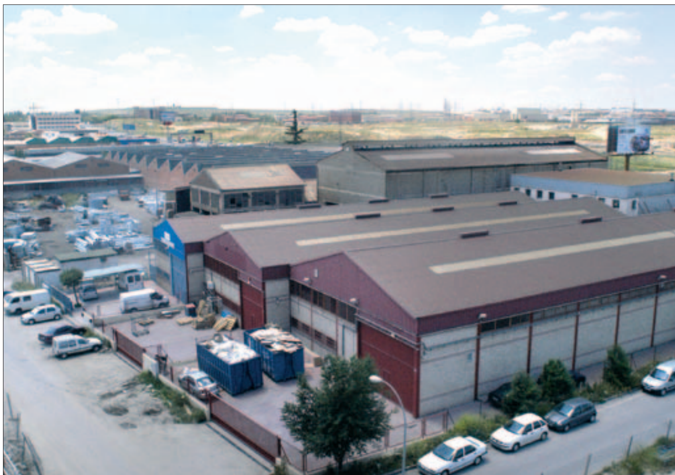
La Consejería de Economía e Innovación Tecnológica destinará fondos para la rehabilitación del polígono de Los Ángeles.
