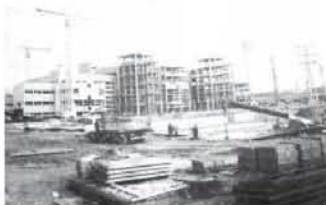
El Hospital de Getafe en obras. Años 1989.
