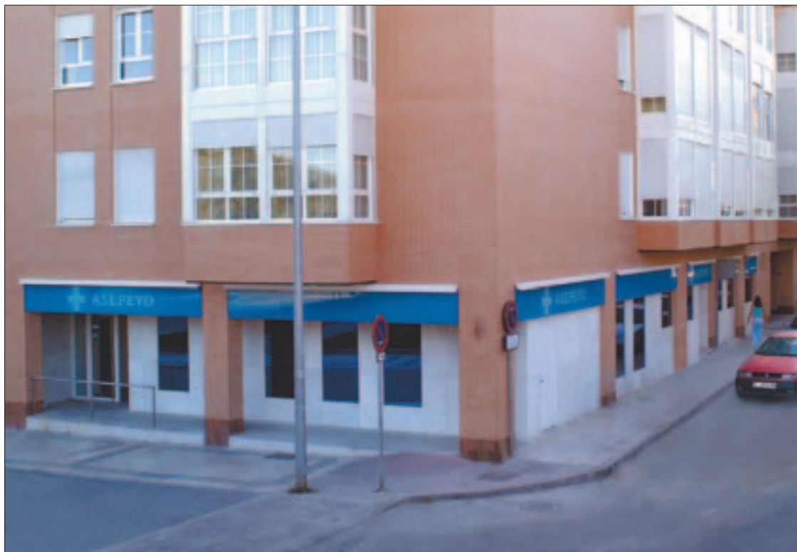
Las instalaciones del nuevo centro asistencial de Getafe, ubicado en la calle San Vicente esquina con la calle Bohime (junto a la delegación de Hacienda), permiten una rápida recuperación.
