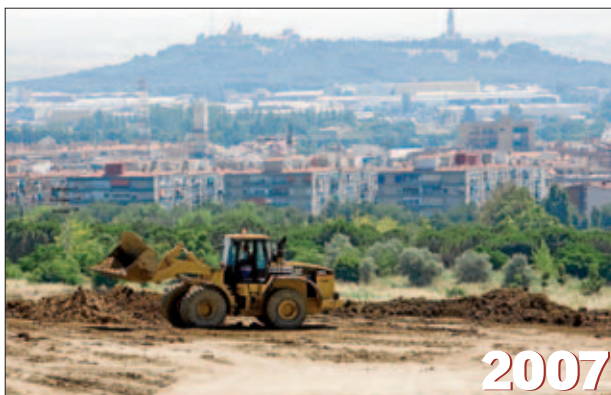
Inicio de las obras de urbanización en Buenavista.
