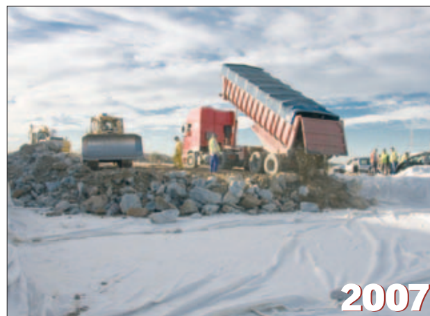
Estado de las obras en Los Molinos en noviembre de 2007.
