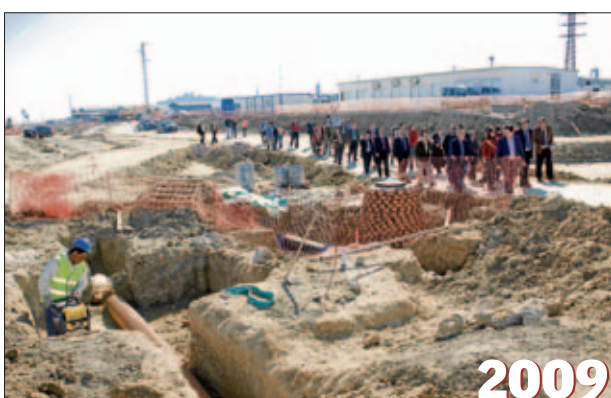
Visita de obras a Los Molinos en marzo de 2009.
