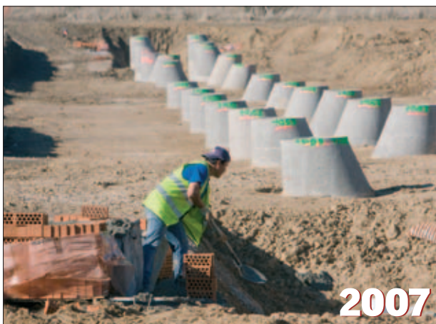
Estado de las obras en Buenavista en noviembre de 2007.
