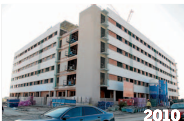
Estado de las obras en Buenavista en octubre de 2010.
