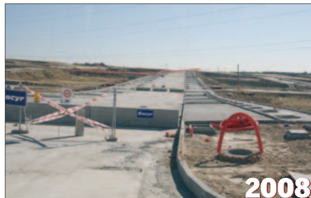
Estado de las obras en Buenavista en agosto de 2008.
