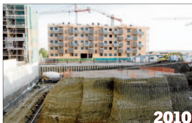
Estado de las obras en Los Molinos en octubre de 2010.
