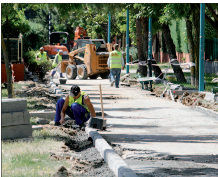
Trabajos en la senda Epi y Blas, una de las peatonales del Sector III que se están remodelando. / David Calle
