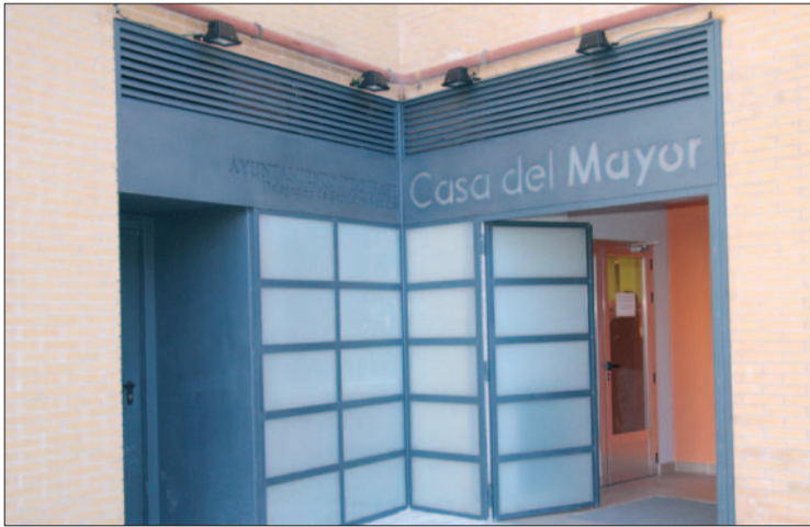
Fachada de la Casa del Mayor, en la calle Manzana.
