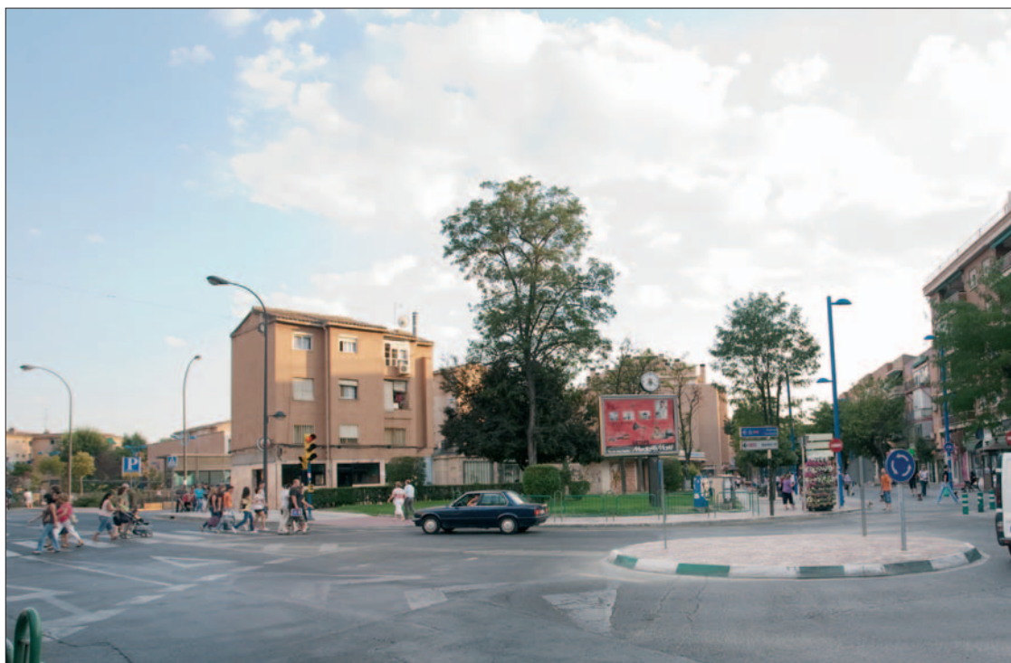
La calle Madrid en su cruce con la avenida Juan de la Cierva, donde se proyecta una “gran plaza”.
