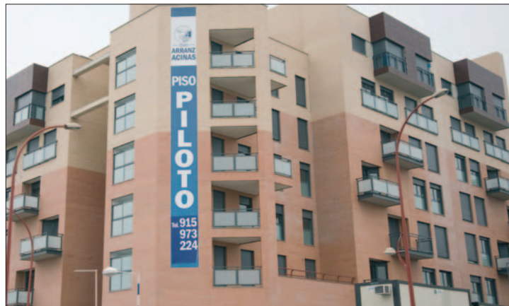
Pisos en venta en la localidad.
