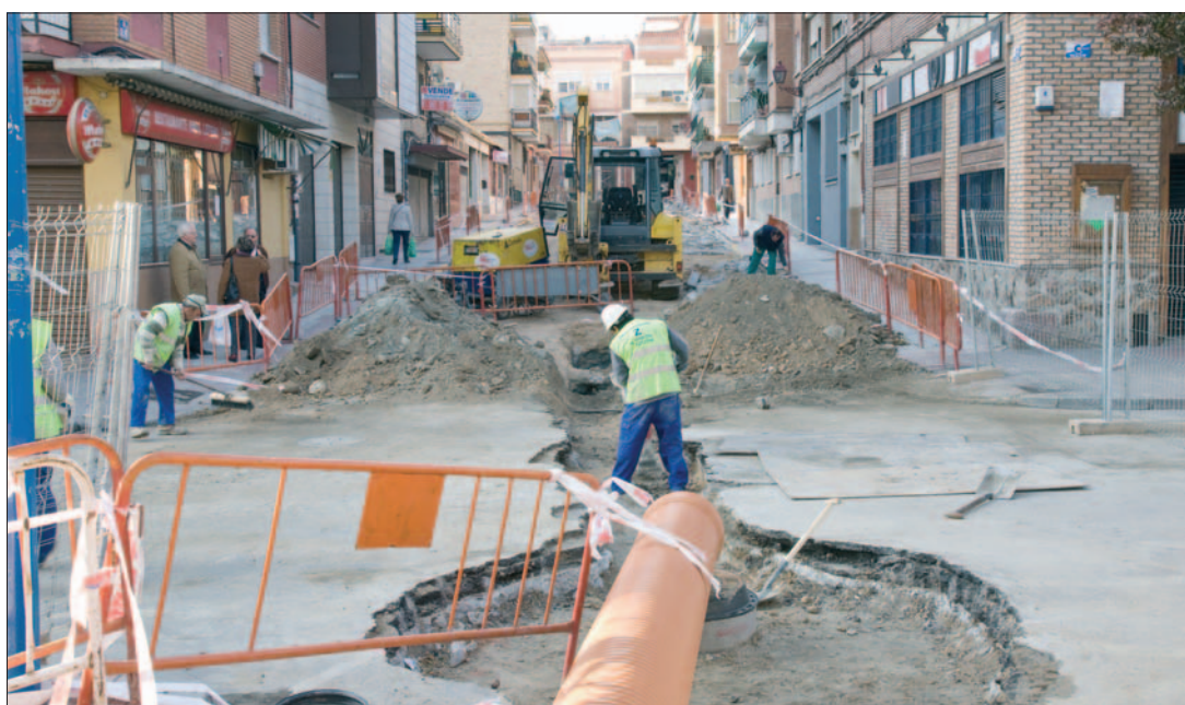
VALLAS Y MÁQUINAS EN LA CALLE OLIVO. LAS OBRAS DE ZAPATERO HAN COMENZADO. Los vecinos ya lo habrán notado. Los trabajos financiados con el llamado Plan Zapatero (Fondo estatal de inversión local) se han puesto en marcha. 13 calles de las 22 previstas para reformar están levantadas; el resto esperan al 6 de abril. Vías cortadas, rutas de autobuses cambiadas... En Juan de la Cierva se han habilitado áreas de aparcamiento. Páginas 10 y 11
