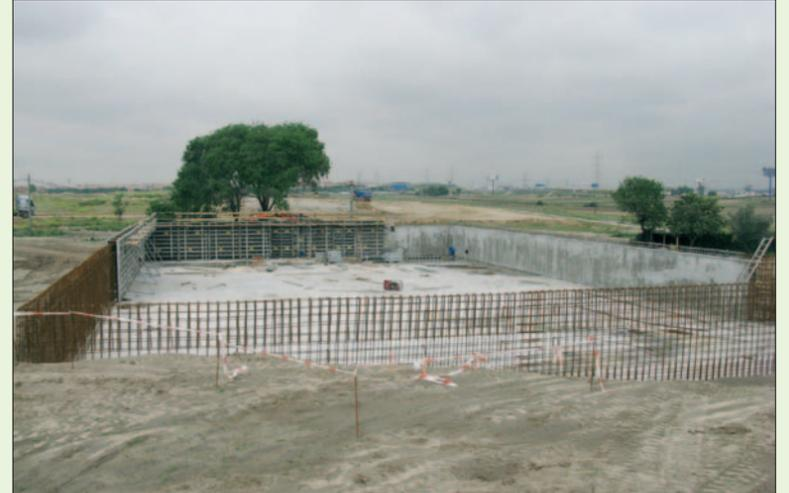
La construcción de la laguna ha necesitado 200.000 kilos de acero para sus armaduras.
