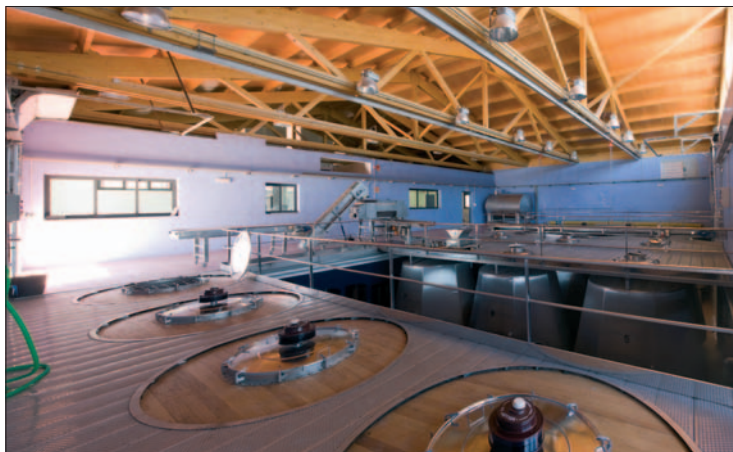
Vista de la parte superior de los depósitos de fermentación.
