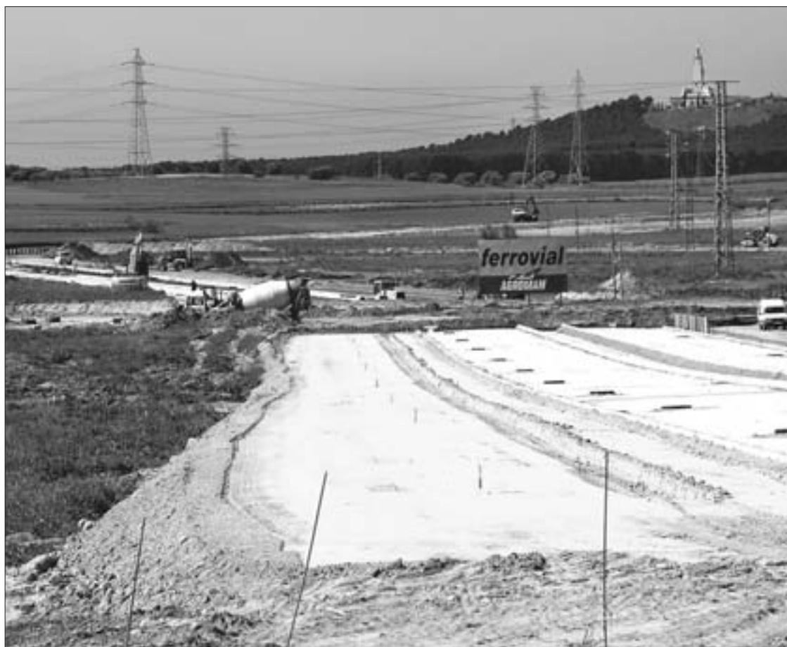
Los primeros trabajos de urbanización del PAU-3 del barrio de Perales del Río, que contemplan la construcción de 1.750 nuevas viviendas en la zona, ya se han puesto en marcha.
