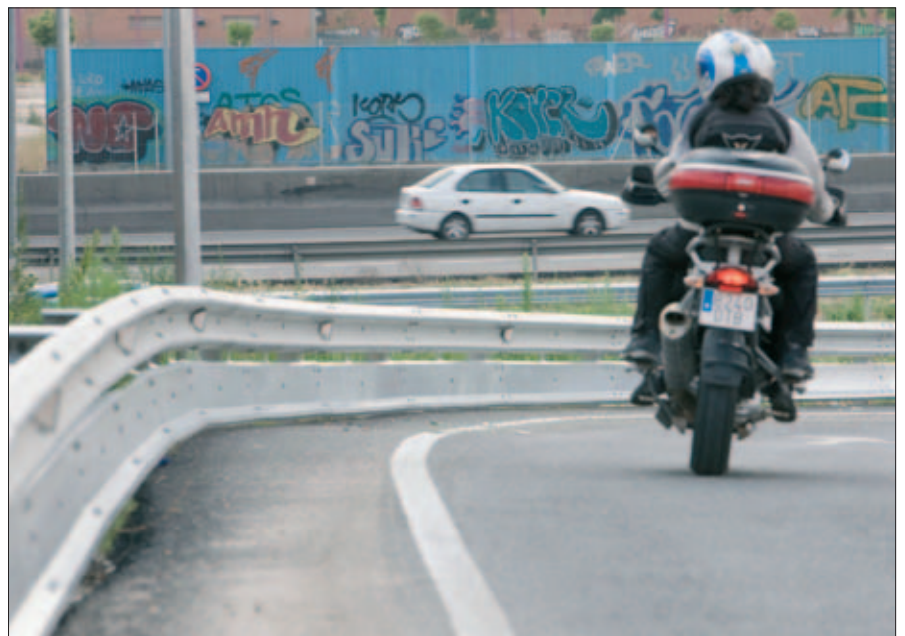
Un poco más protegidos. Así se pueden sentir los motoristas al pasar por alguno de los accesos de El Bercial Universidad donde se han instalado unos novedosos guardarraíles con unas placas metálicas que evitan que en caso de accidente el vehículo se deslice por debajo y provoque amputaciones y cortes en el conductor. La retirada de los tradicionales quitamiedos de las carreteras es una de las reivindicaciones más demandadas por los conductores de motos.
