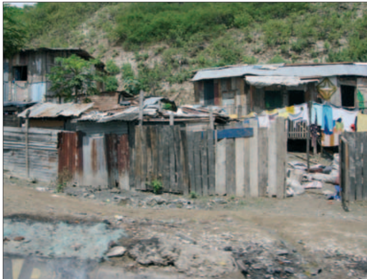
Infraviviendas en la región ecuatoriana de Manabí.
