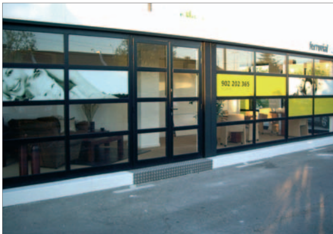
Caseta de venta de Ferrovial, sita en el aparcamiento de Urende (carretera de Getafe a Leganés).
