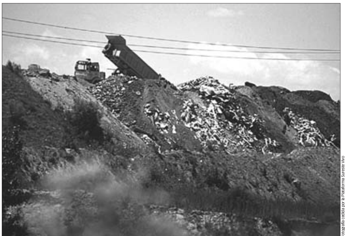
Según el acuerdo alcanzado en la junta rectora del Parque Regional del Sureste, sólo se permitía el vertido de tierras limpias procedentes de las obras del MetroSur. En la práctica no es así.
