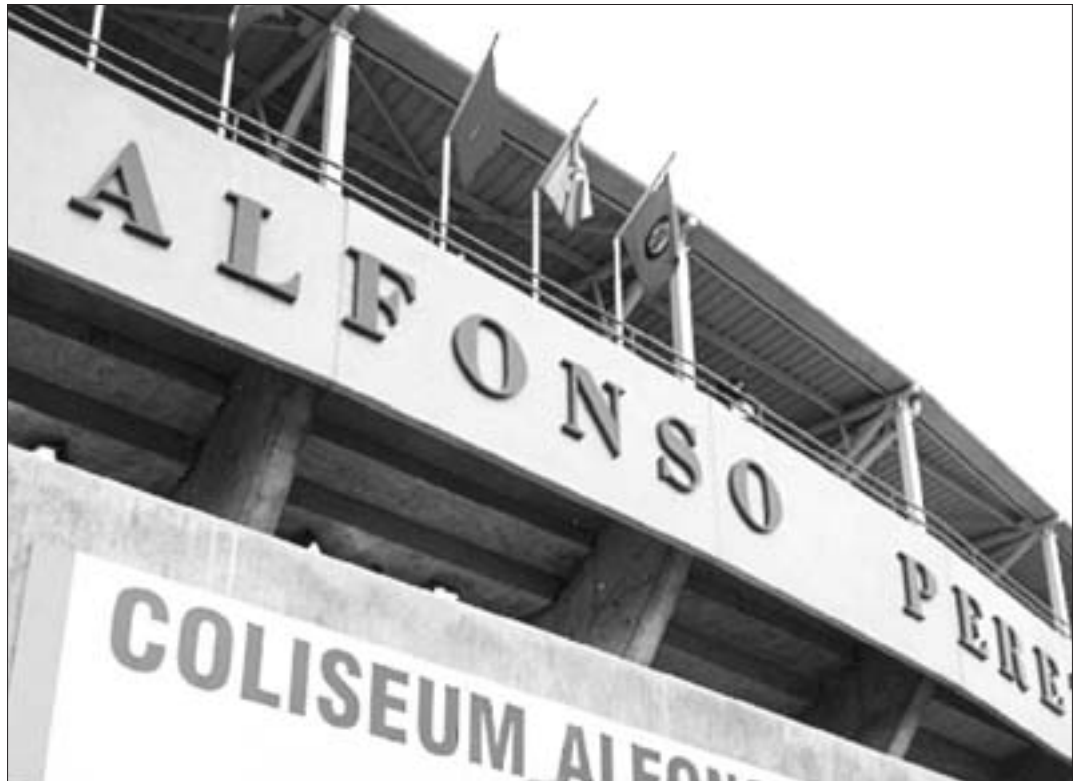
Las instalaciones del equipo de fútbol del Getafe se modernizarán en los próximos años.
