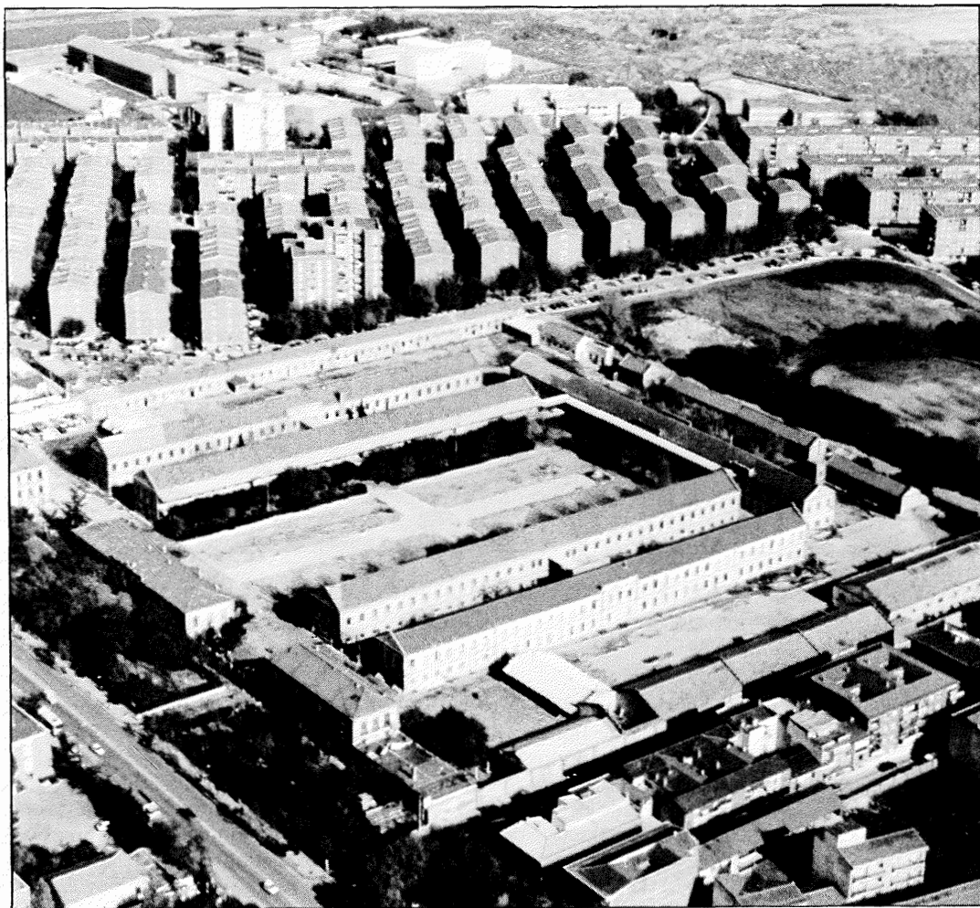
El antiguo cuartel de Artillería.
