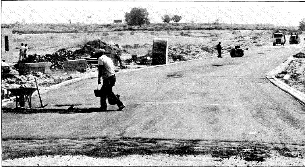
Las obras de urbanización del polígono de San Marcos están recibiendo los últimos retoques.
