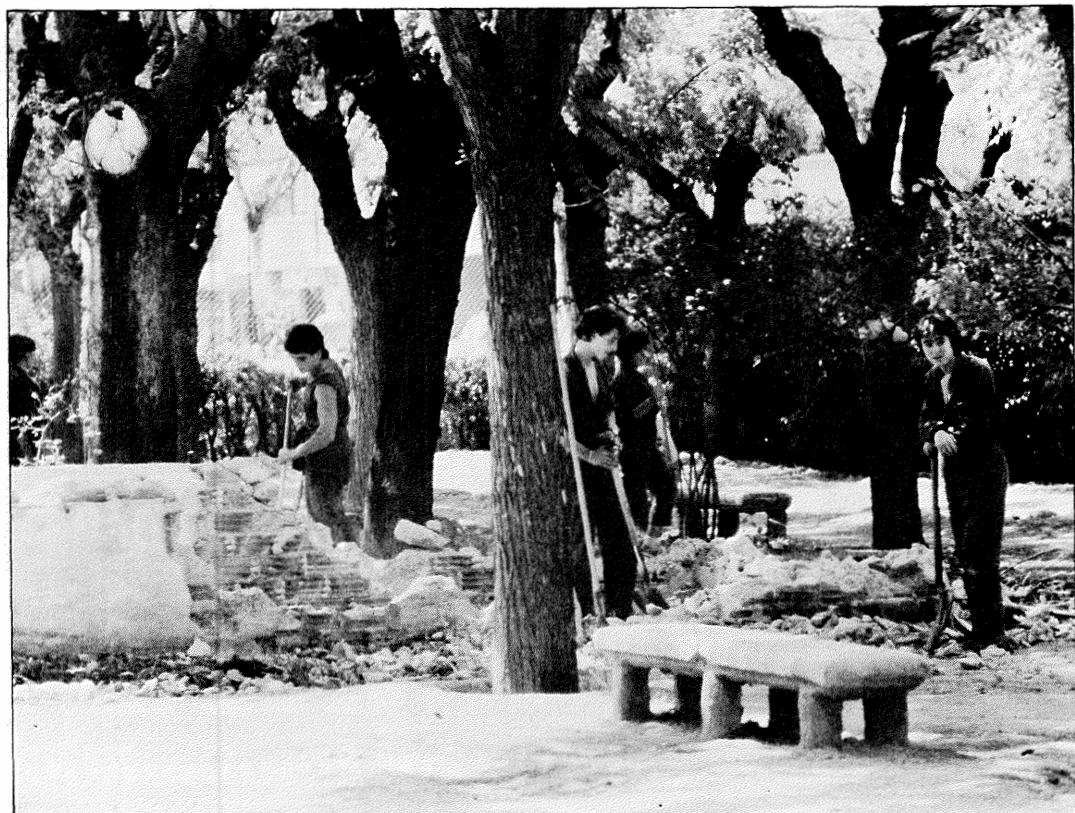
Alumnos de la Escuela-Taller trabajan en la restauración del Parque de Artillería.
