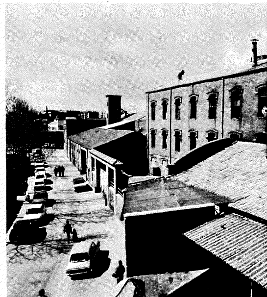
Perspectiva de todo el edificio.
