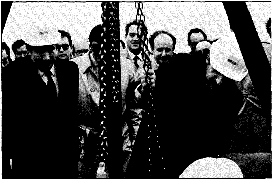
El Ministro procede a la instalación de la primera tapa de la red de colectores ya construidos.
