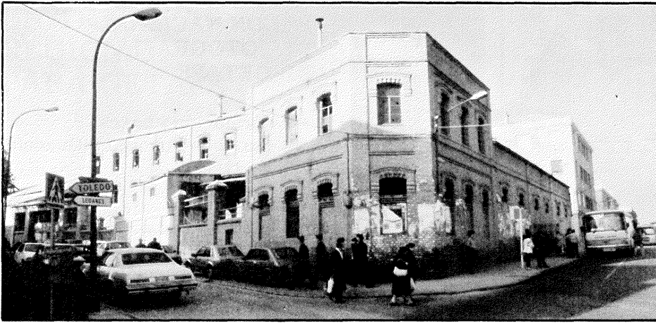
Los viejos edificios de Getafe, como la Fábrica de Harinas, serán uno de los objetivos de la Escuela-Taller.
