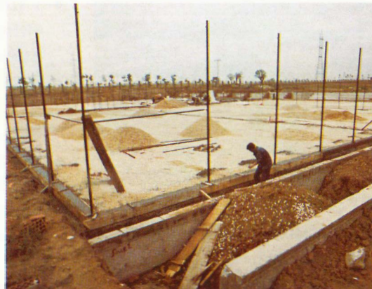
Las 6 pistas de tenis, ya en avanzado estado de ejecución.
