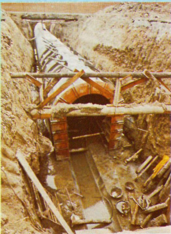
El colector C-4, que ya está prácticamente terminado.
