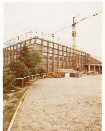
Nuevo pabellón cubierto, en el Polideportivo San Isidro.
