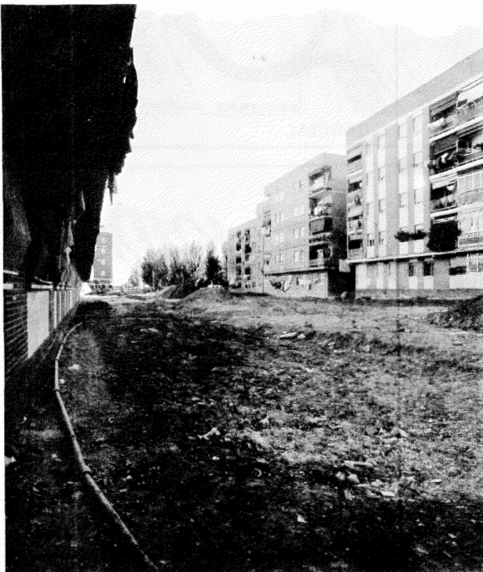
Vista del estado actual del interbloque de las calles Teruel y Murcia.
