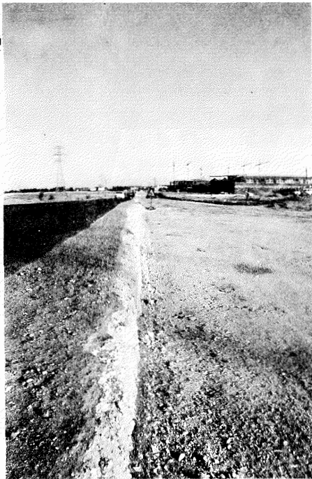
El desdoblamiento de la carretera a Leganés ya en marcha, descongestionará el tráfico entre los dos pueblos y permitirá un rápido acceso al hospital y las instalaciones del Sector III.
