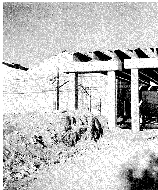
Un paso a distinto nivel en el polígono de
