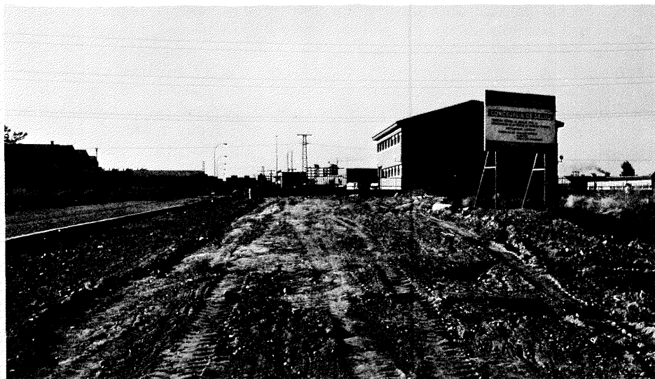
En primer plano, el terreno cedido para ambulatorio en El Bercial. Al fondo, el nuevo colegio.
