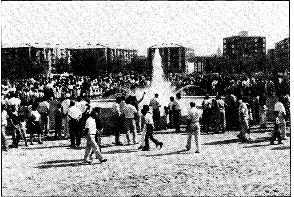
Durante la inauguración fue puesta en marcha, provisionalmente, la fuente artística que está situada en el extremo del Parque más cercano a las viviendas. (Foto: J. R. Valenzuela).
